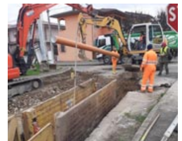
I lavori a Bovolone
