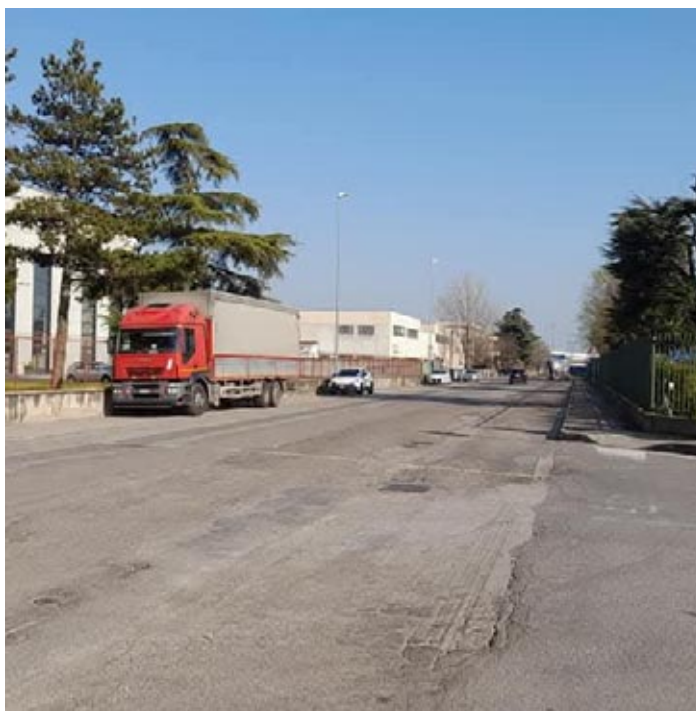
Partono i lavori di asfaltatura nella zona industriale
