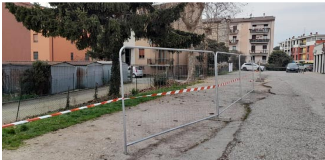
Partono i lavori per la nuova ciclabile in Via Venezia
